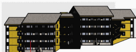
Façade Sud-Ouest ①
