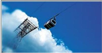
Un téléphérique rénové en 2003 : d'un débit horaire de 800 personnes / heure, il permet d'accéder au Plomb du Cantal à la vitesse de 10 mètres à la seconde ! Deux cabines d'une capacité de 80 personnes parcourent 2336 mètres de la station au sommet, soit 552 mètres de dénivelé.
